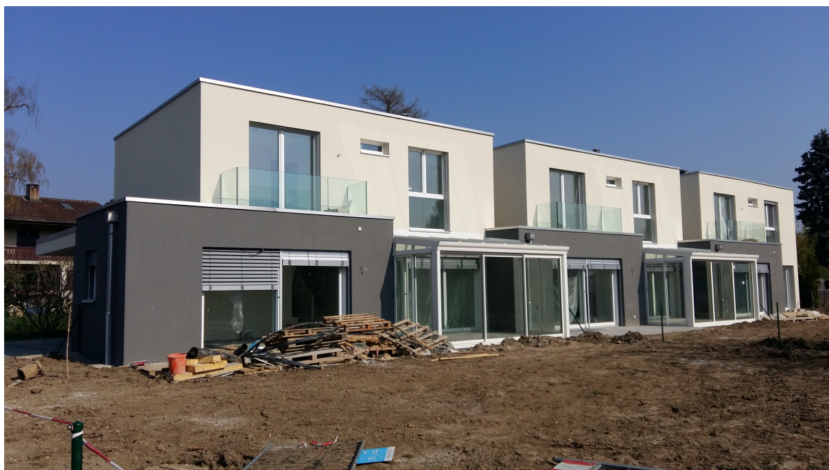
Série de villas en construction à PLO
