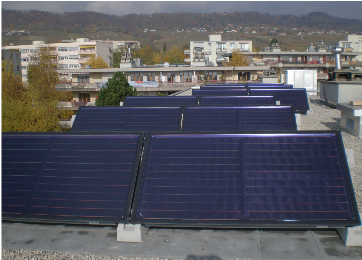
Photos d'un montage de capteurs thermiques sur le toit d'un immeuble locatif sur la Côte.
