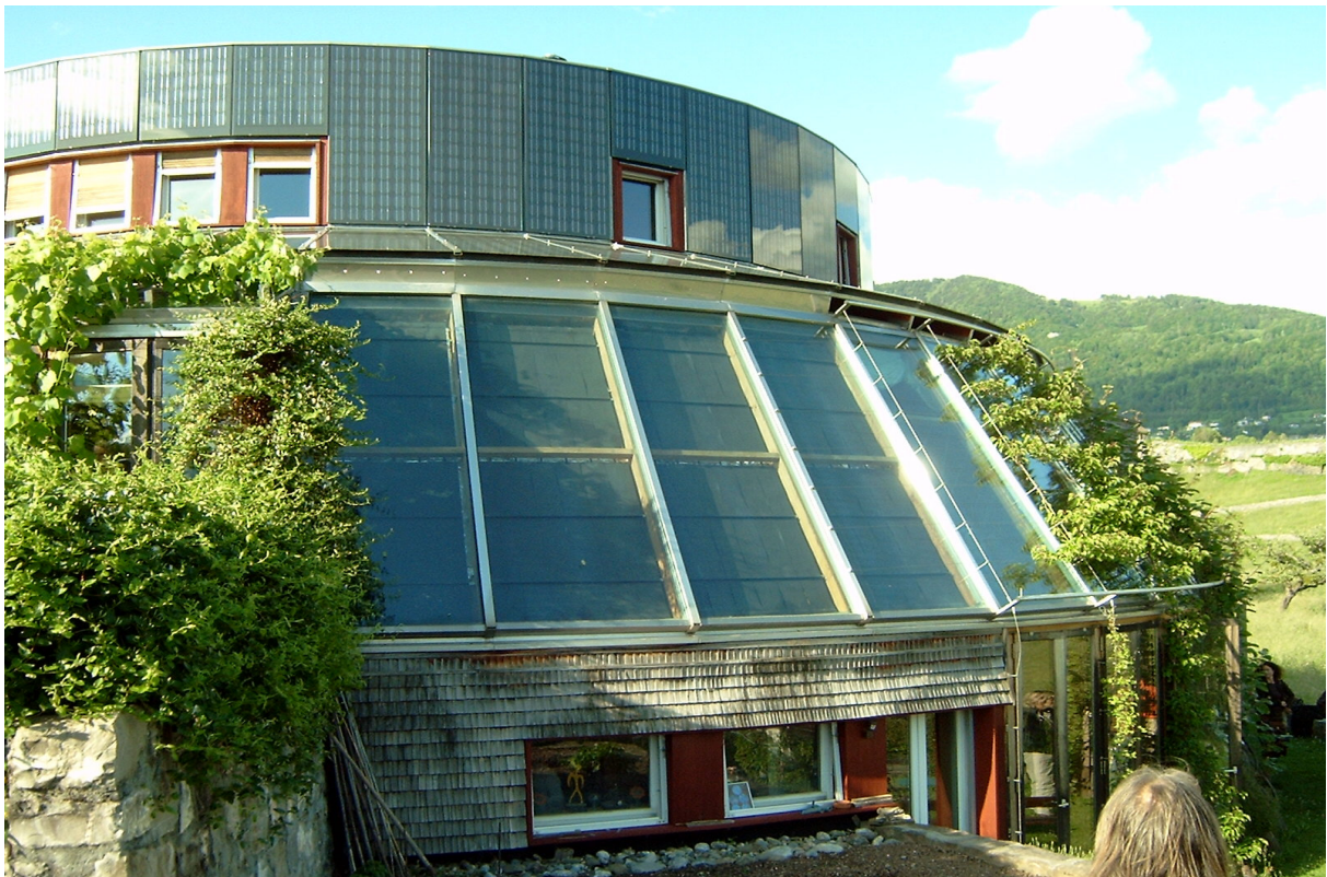
D'aspect insolite, la maison clé de sol sur les hauteurs de Vevey est équipée de panneaux solaires photovoltaïques dans sa partie supérieure et de capteurs solaires thermiques protégés à l'abri de la véranda.
