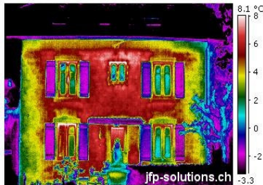
Thermogramme de la façade extérieure. Notons la relative efficacité des double vitrages
