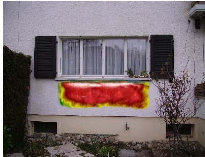
Photo montage incrustant le thermogramme où le radiateur est nettement visible dans la photo d'origine.
