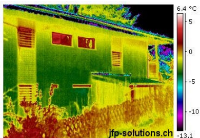
Thermogramme de la façade extérieure
