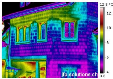
Thermogramme de la façade extérieure
