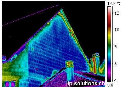
Thermogramme du mur pignon. Notons l'excellente isolation de la toiture
