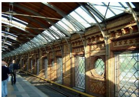
Station S-bahn près de Hackesche Höfe.
