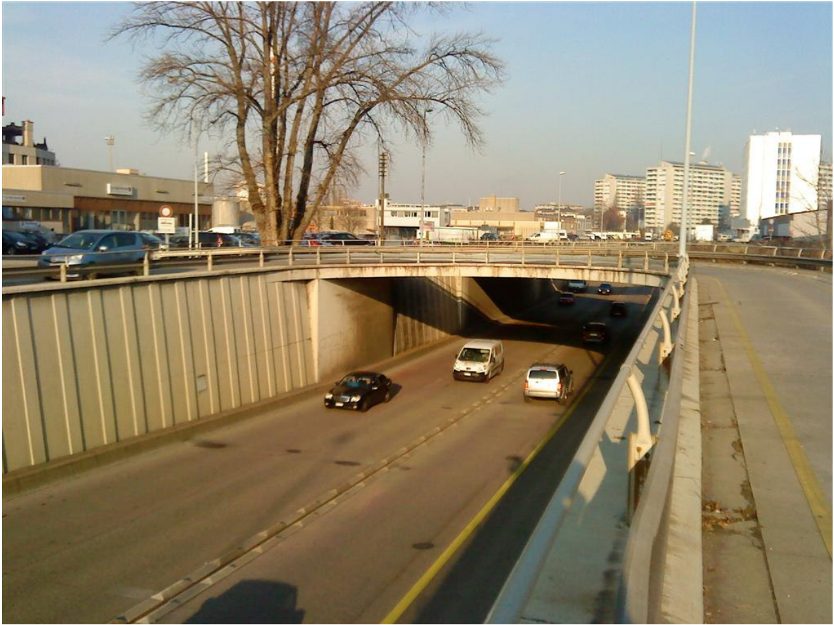
Environ 4 tranchées par pôles ; certaines sont déjà en place.
